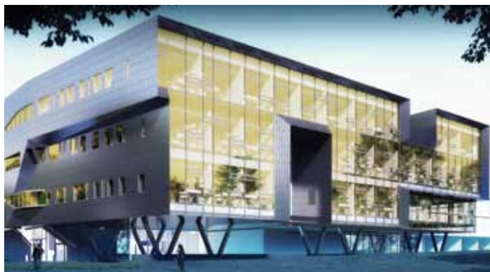
Le Centre Stephen Hawking de l'Institut Perimeter
